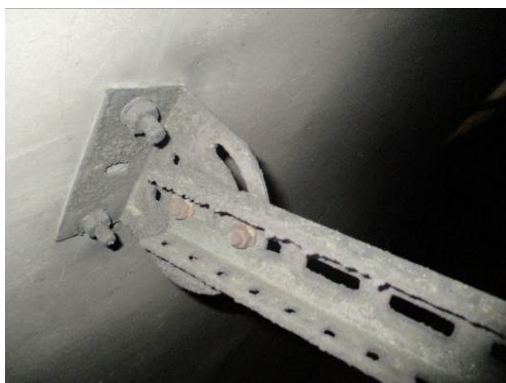
Foto con evidenza della non orizzontalità della canalizzazione nel tunnel Valdagno-Schio pass
