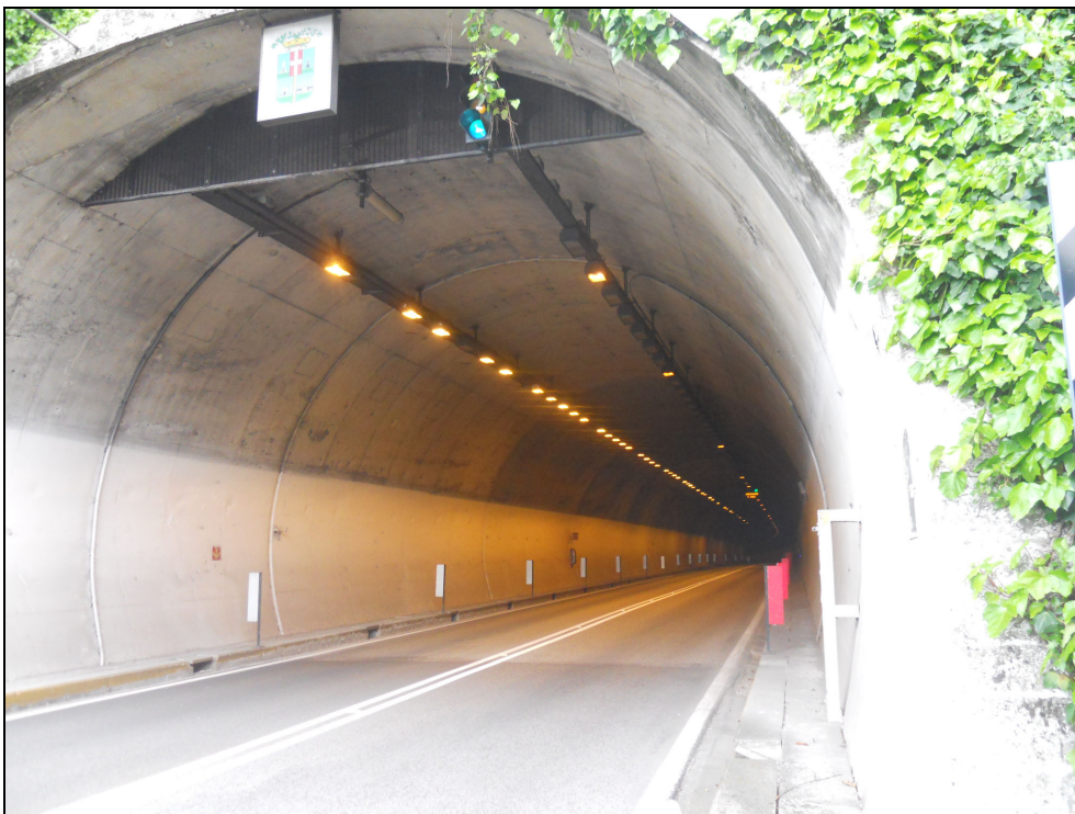
Foto imbocco lato Schio con la posizione degli apparecchi illuminanti esistenti
