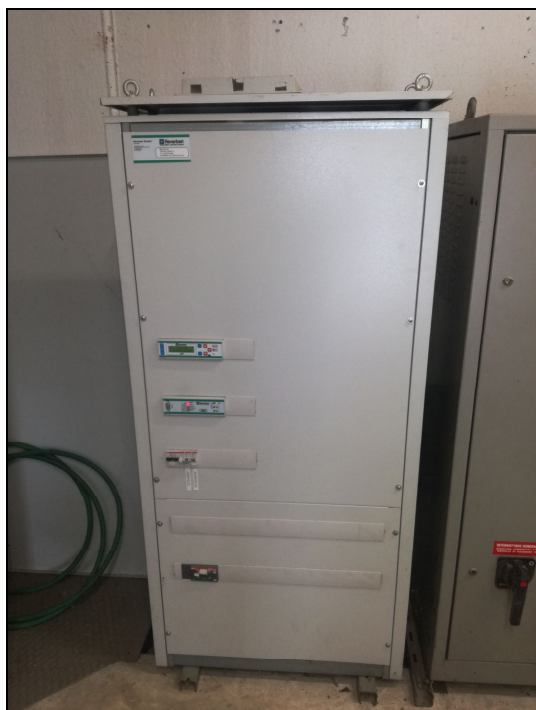
Regolatori di flusso esistenti per la gestione della permanente
