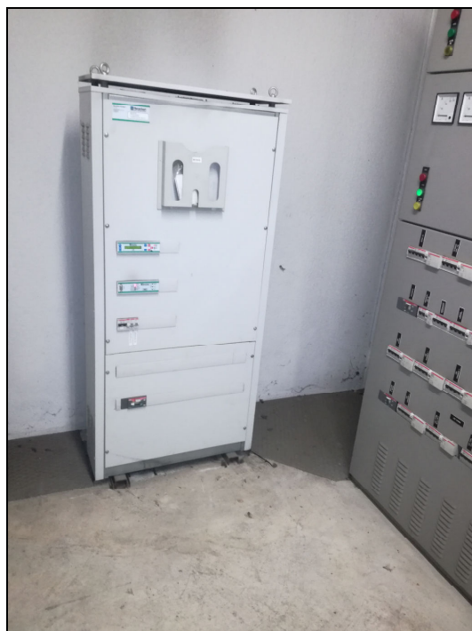
Regolatori di flusso esistenti per la gestione della permanente
